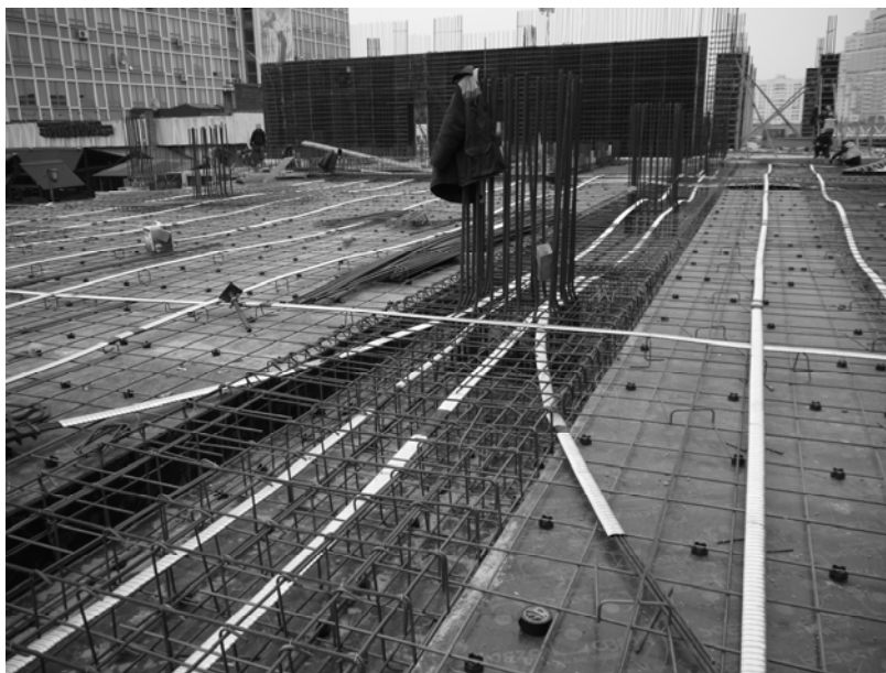
Рис. П4.6. Монтаж системы предварительного напряжения. Общий вид конструкции
