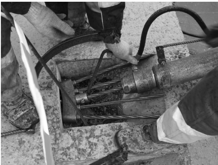
Рис. П4.9. Установка домкрата в рабочее положение при расположении анкера на верхней грани плиты
