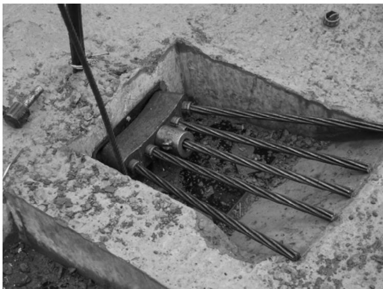
Рис. П4.7. Анкерный блок и цанги, установленные в положение перед натяжением. Проставка на пряди служит для правильного приложения усилия при возможности отклонения оси домкрата от оси пряди
