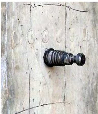
Рис. 1.4. Установленный анкер
