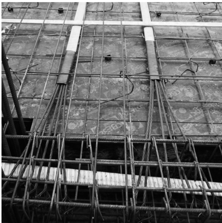
Рис. П4.4. Герметизация каналобразователя с пассивной стороны пучка клейкой лентой
