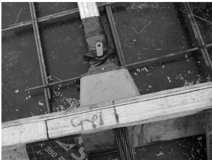
Рис. П4.1. Монтаж анкерного узла. На опалубке отмечено место установки закладной детали и нанесен номер пучка. Деталь между закладной и бортом опалубки – нишеобразователь
