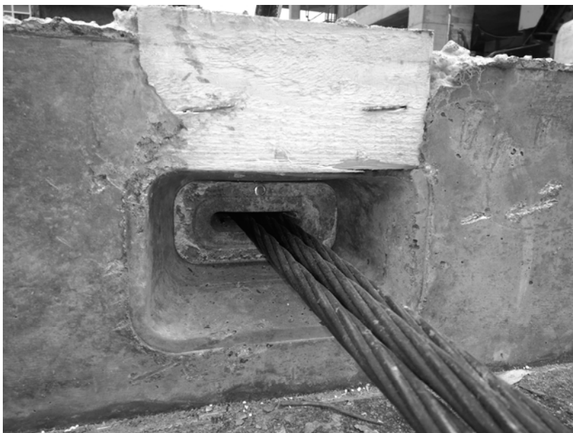
Рис. П4.12. Извлекаемый отрезок доски позволяет облегчить процедуру замоноличивания анкерной ниши. К торцевой плоскости плиты приставляется деталь опалубки, а заполнение ниши бетоном ведется сверху через полученный за счет извлечения доски паз
