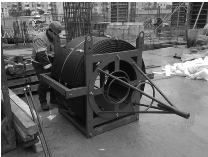
Рис. ПЗ.1. Моток канатной арматуры, установленный в диспенсер
