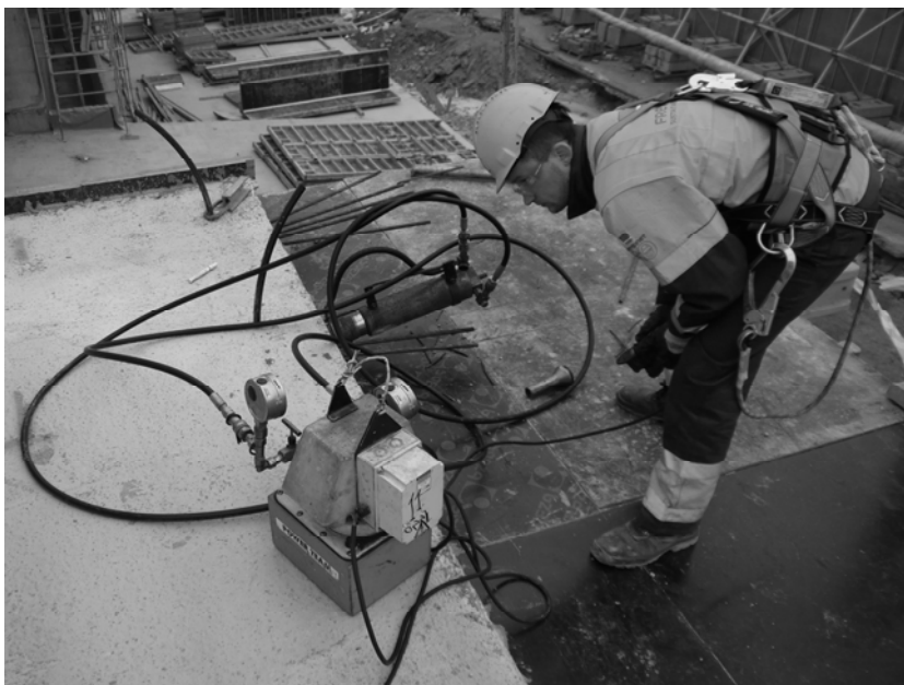
Рис. П4.11. При натяжении выполняется непрерывный контроль давления в гидравлической системе
