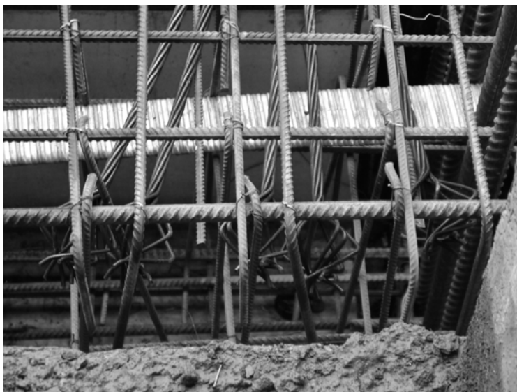
Рис. П4.3. Луковичеобразные анкеры на пассивных концах прядей
