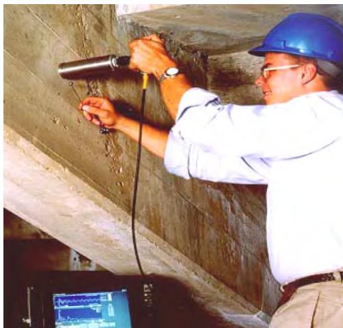
Рис. 1.22. Контроль состояния балки методом Impact-Echo
