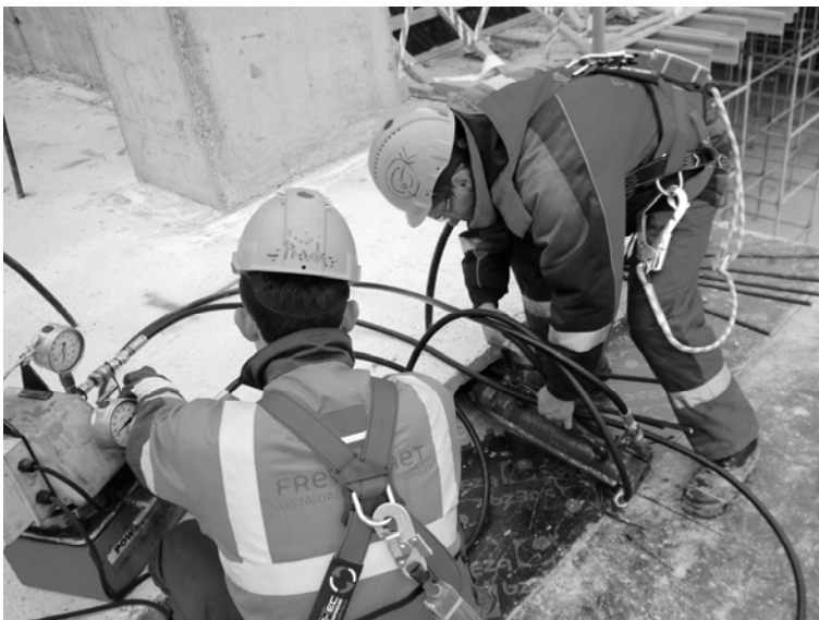
Рис. П4.10. Установка домкрата в рабочее положение при расположении анкера на торце плиты
