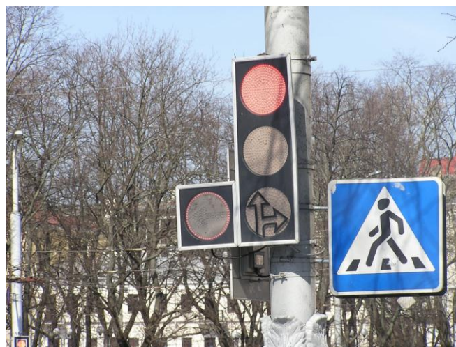
Рис. 5. Светофор Т.1л(к) (г. Минск, перекресток улиц Свердлова – Кирова)
