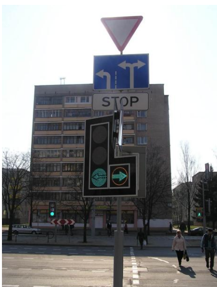
Рис. 4. Светофор Т.1п(кж) (г. Минск, перекресток Логойский тракт – улица Кольцова)
