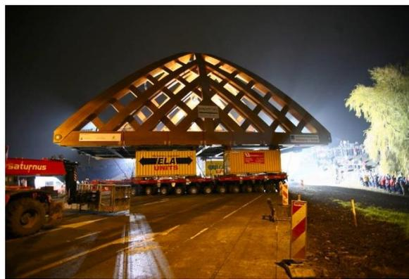
Рисунок 3 – Транспортировка готовой конструкции к месту установки
