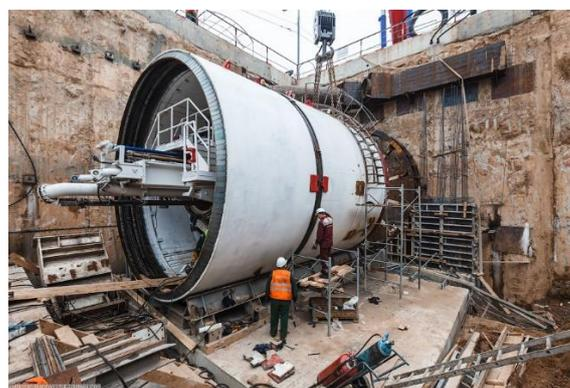
Рисунок 3 – Строительство тоннеля метрополитена щитовым способом
