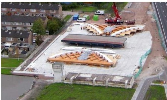
Рисунок 2 – Сборка моста
