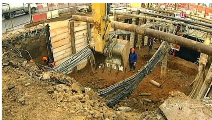
Рисунок 2 – Строительство подземного пешеходного перехода открытым способом
