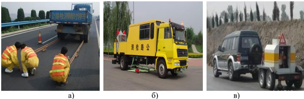
Рисунок 3 – способы измерения упругого прогиба
