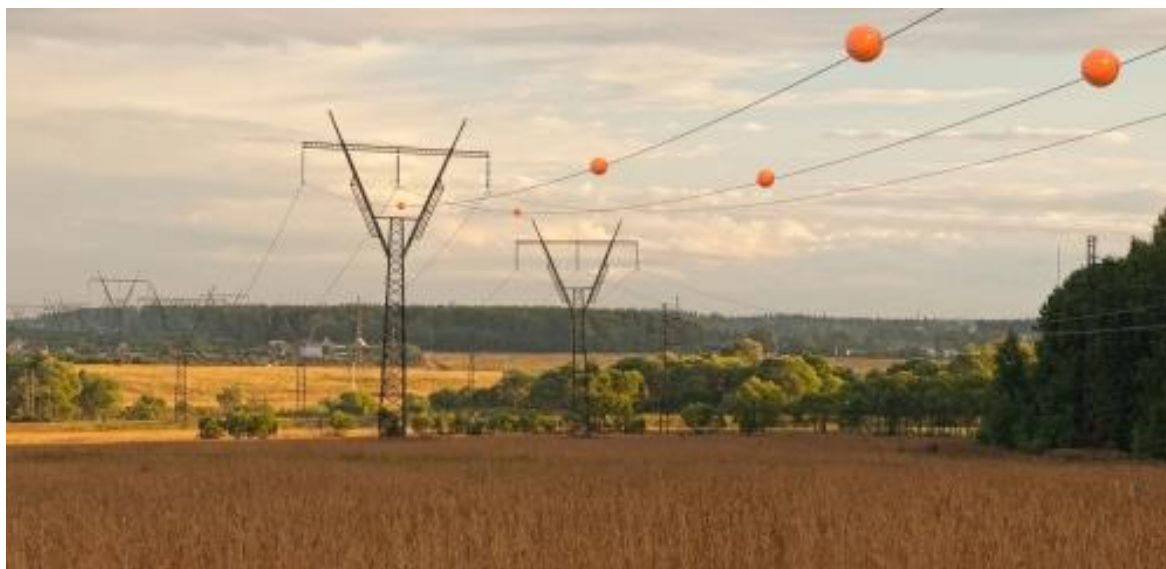
Рисунок 4. Маркеры для воздушных линий электропередачи
