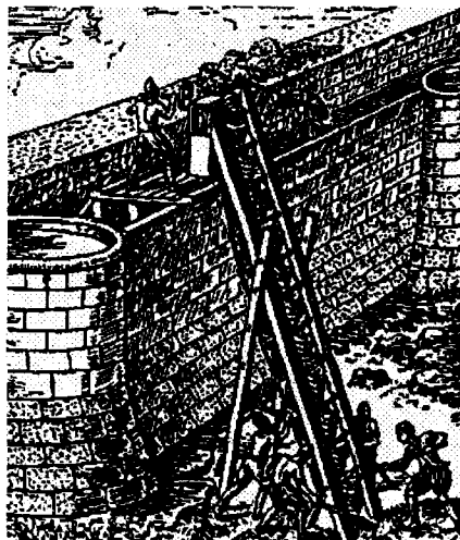
Рис. 3.1. Применение для строительства крепости ковшового подъемника с ручным приводом
