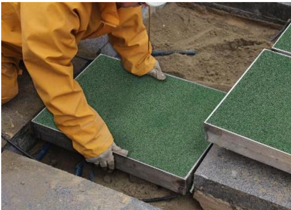
Рисунок 3. Процесс установки тротуарной плитки, генерирующей электроэнергию
