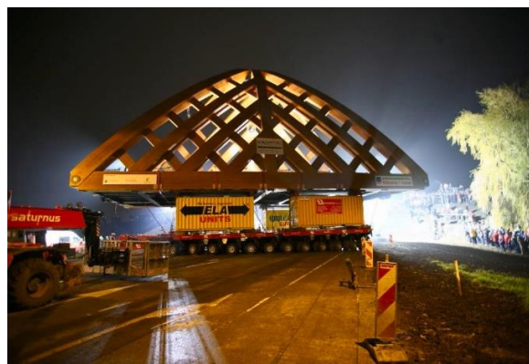
Рисунок 3 – Транспортировка готовой конструкции к месту установки
