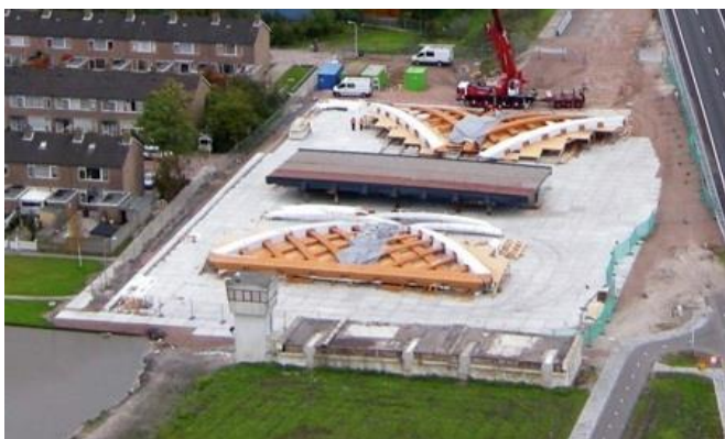
Рисунок 2 – Сборка моста
