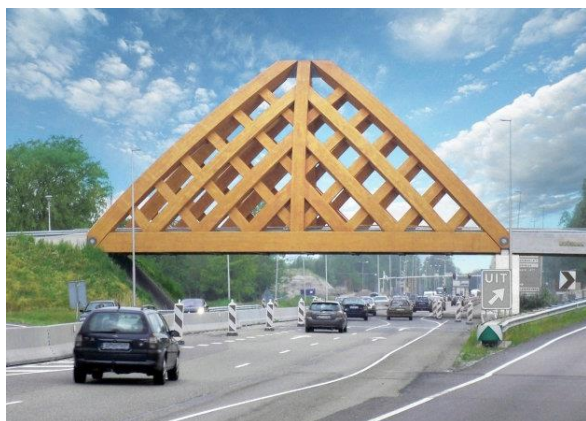
Рисунок 2 – Путепровод в г. Снек, пересекающий автомагистраль А7
