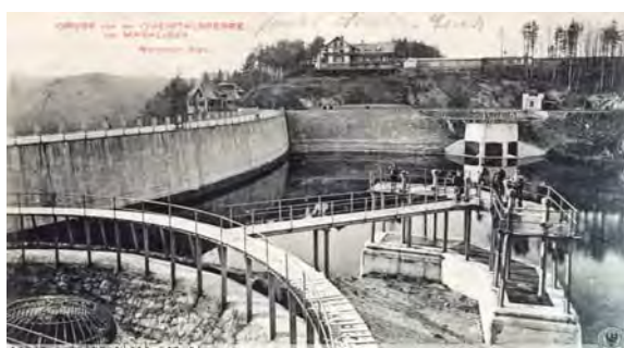
Рисунок 5 – Колодцы сброса поводковых вод
