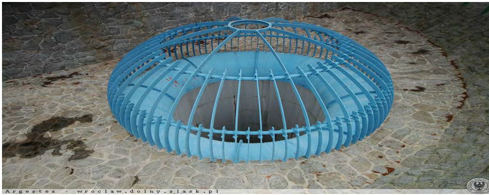
Рисунок 7 – Колодец отвода поводковых вод
