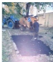
Рис. 8. Укладка асфальтобетонной смеси, приготовленной на установке РДЖ - 2800
