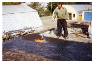
Рис. 6. Нанесение слоя порошка из КБО и расплавление его газовой горелкой (пат. ВУ 12265)
