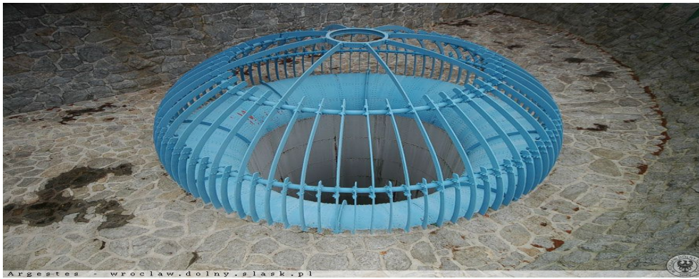
Рисунок 7 – Колодец отвода поводковых вод
