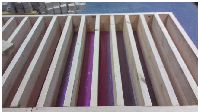
Рис. 2. Деревянная опалубка для изготовления опытных образцов
