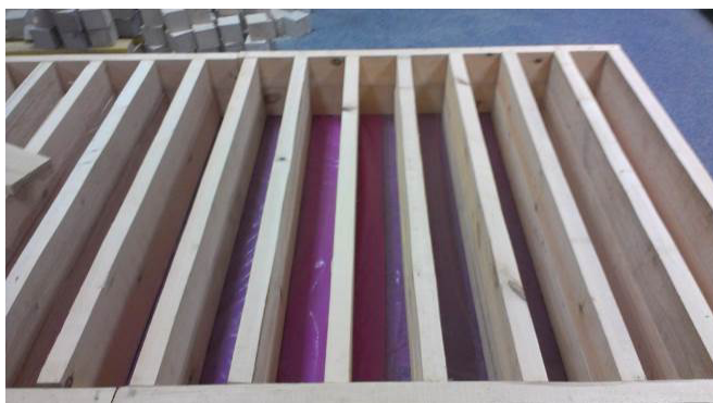
Рис. 2. Деревянная опалубка для изготовления опытных образцов
