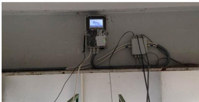
Рис. 3. Блок сбора обработки и выдачи информации
