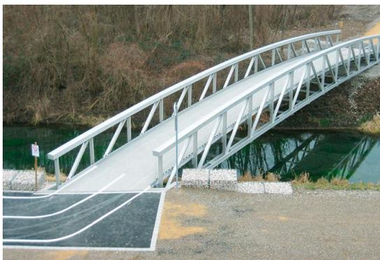
Рисунок 1 – Мост из алюминиевых сплавов
