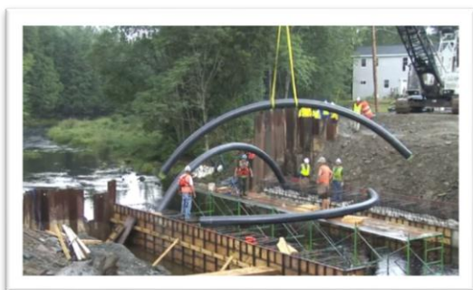
Рисунок 1 – Монтаж первых арок будущего моста.
