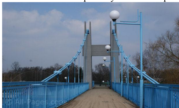
Рисунок 4 – Мост через р. Мухавец, г. Брест. Вид с полотна моста
