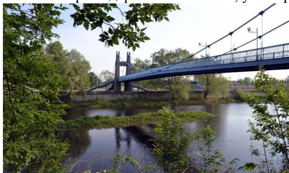
Рисунок 3 – Мост через р. Мухавец, г. Брест.
