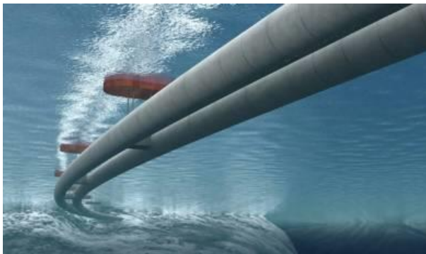
Рис. 1 – Подводные мосты в виде двух туннелей
