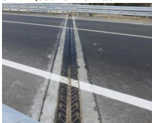
Рис.1 Деформационный шов КРМ.
