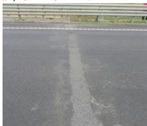
Рис.2 Щебеночно-мастичный деформационный шов
