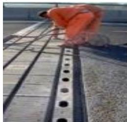
Рис. 4 Монтаж системы Uniblok
