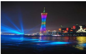
Рис.1. Телебашня «Canton Tower» высотой 600м (г. Гуанчжоу).
