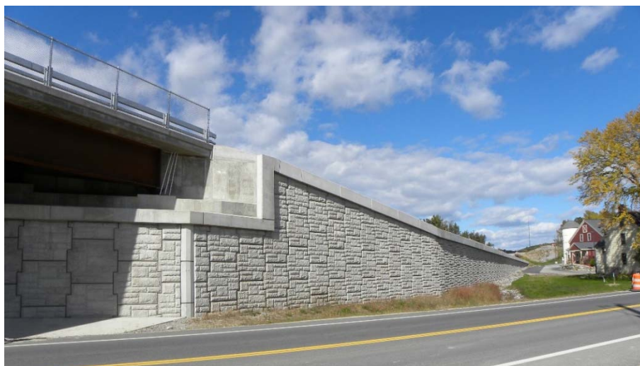
Рисунок 1 – Общий вид подпорной стенки
