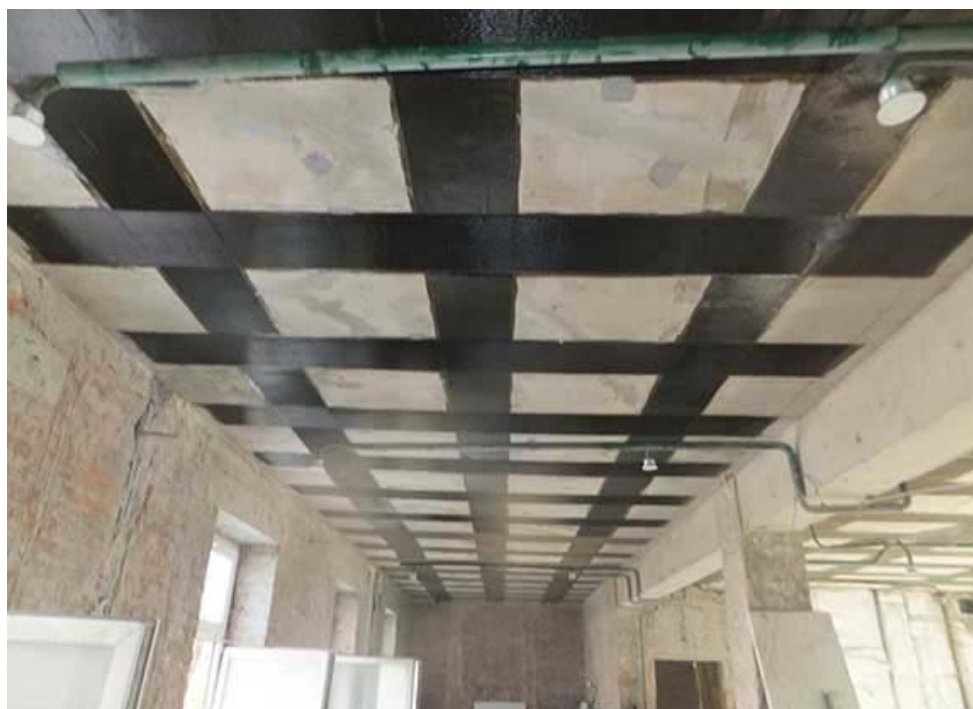
Рисунок 3 – Усиление пролетного строения
