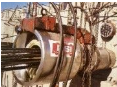
Рис. 4.1. Процесс натяжение арматуры на бетон конструкции
