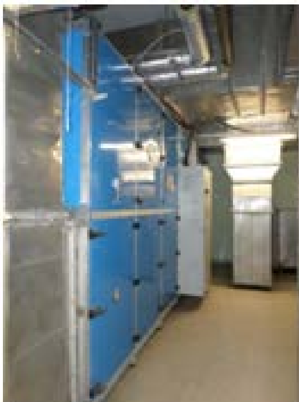
Рисунок 6 – 14-рядные гликолевые теплоутилизаторы Mountair AG
