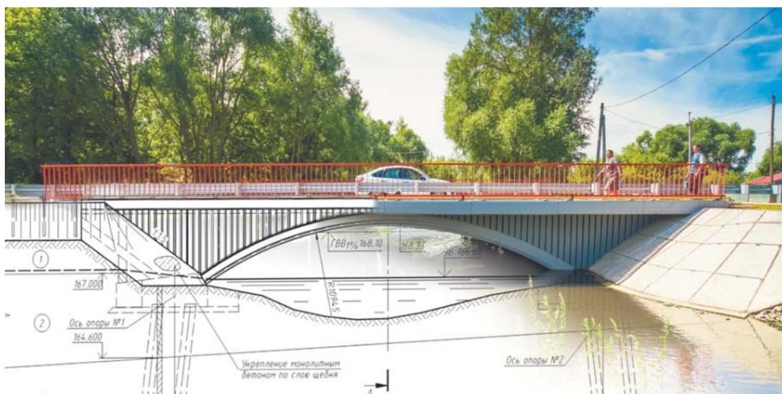
Рисунок 1 – Углепластиковый мост в Ульяновской области
