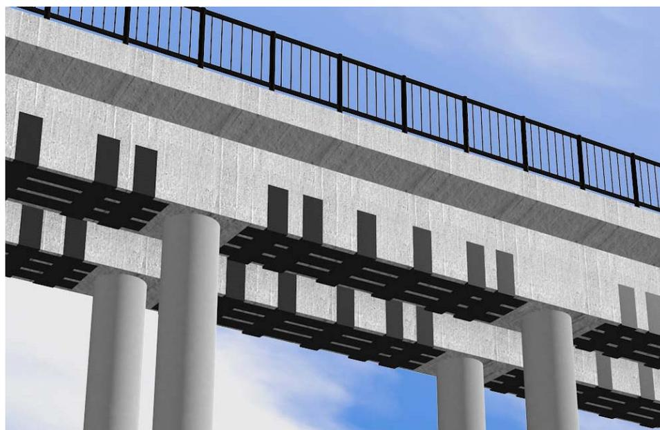
Рисунок 2 – Усиление моста углепластиком
