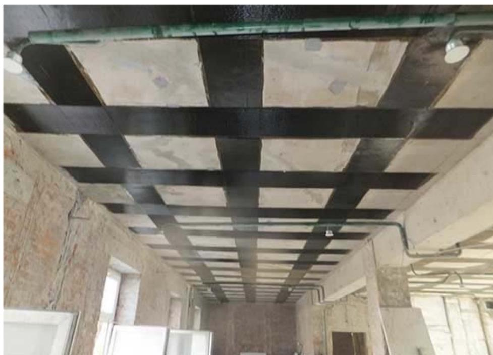
Рисунок 3 – Усиление пролетного строения
