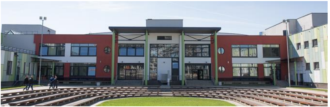
Рисунок 5 - Главный фасад школы № 61 в г. Минске
