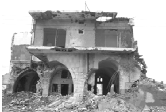
Рис. 4. Традиционный каменный жилой дом с бетонной надстройкой
