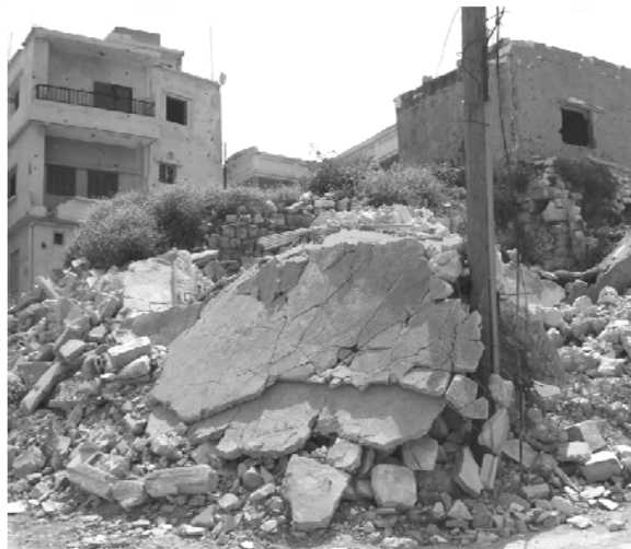
Рис. 5. Современные бетонные жилые дома
