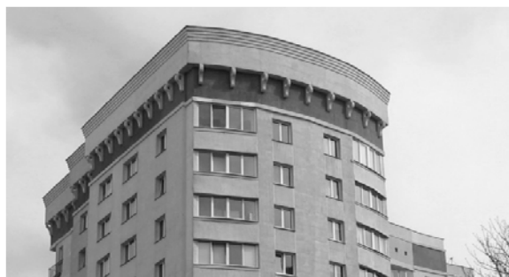
Рис. 5. Устройство венчающего карниза жилого дома по ул. Л. Беды в г. Минске
