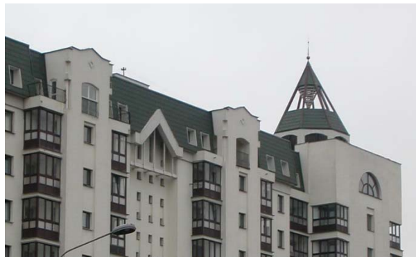
Рис. 6. Фальшкровля в жилом доме по ул. Куйбышева в г. Минске
