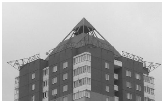
Рис. 8. Металлические детали в оформлении завершения жилого дома по ул. Старовиленской в г. Минске
