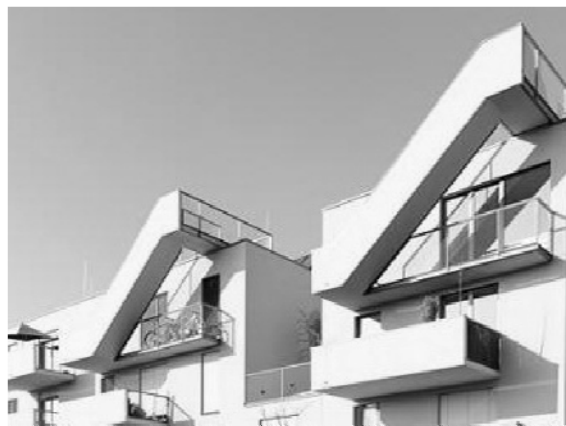
Рис. 2. Устройство индивидуальных выходов на крышу в жилой дом в г. Грац (Австрия)
