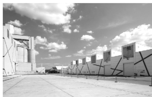
Рис. 3. Цементный завод фирмы Страбаг в Сентлеринце, Венгрия
