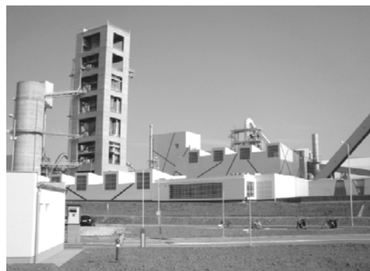
Рис. 2. Цементный завод фирмы Страбаг в Сентлеринце, Венгрия
