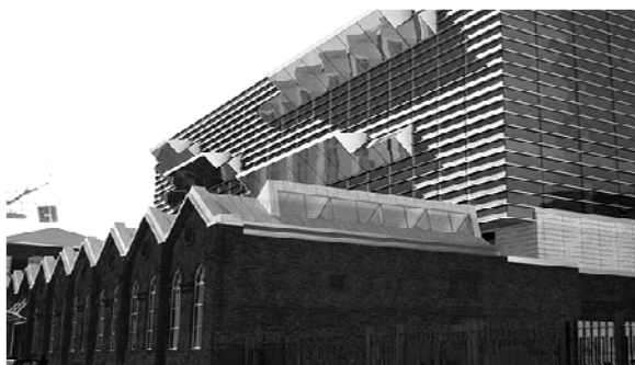
Рис. 2. Новая застройка территории фабрики «Красная роза» в Москве
