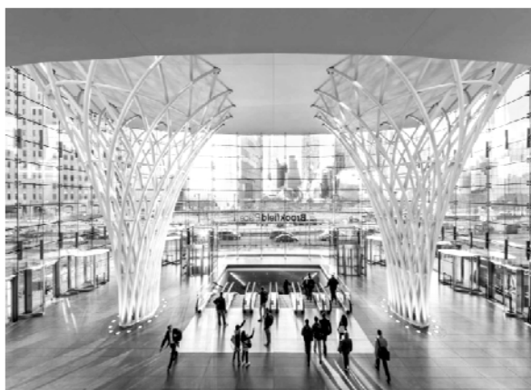
Рис. 6. Входной павильон здания Brookfield Place в Нью-Йорке
