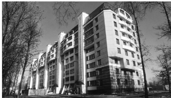
Рис. 1. Общий вид жилого дома после реконструкции в г. Москва, Россия
