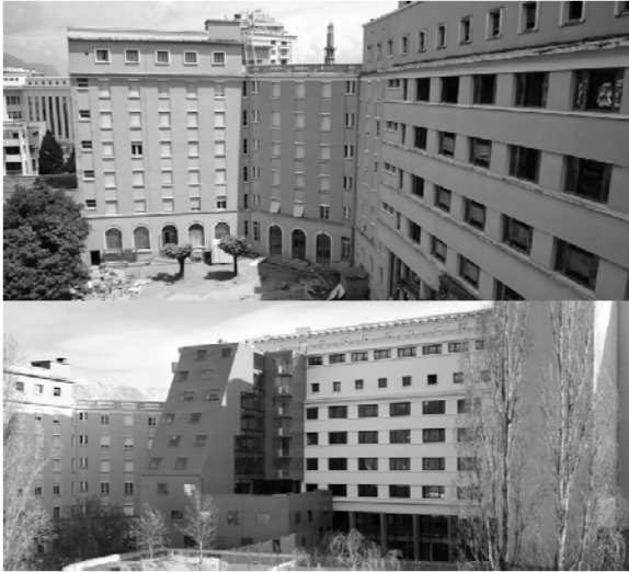
Рис. 4. Общий вид студенческого общежития до и после реконструкции в г. Гренобль, Франция
