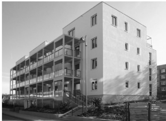
Рис. 8. Общий вид жилого дома после реконструкции в г. Зондерсхаузен, Германия
