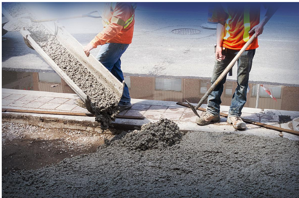
Рисунок 9 - Укладка бетона
