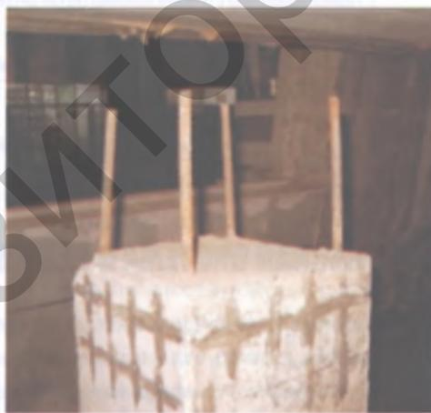
Рис. 3.3 – Фрагмент колонны верхнего этажа по второму варианту с выпусками арматуры в проектном положении
