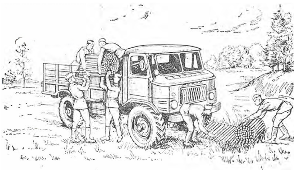
Рис. 3.14. Укладка колейных дорожек из прутьев
