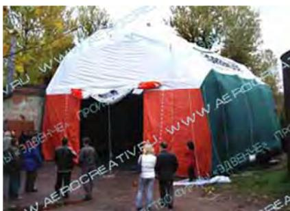
Рис. 5.14. Пневмокаркасная палатка
