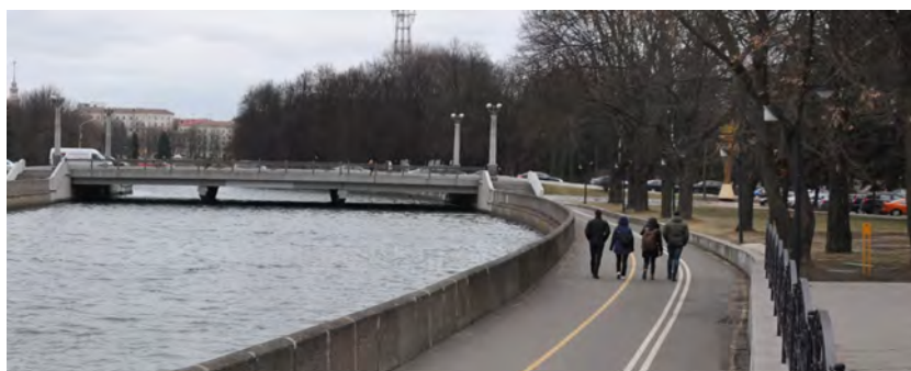
Рис. 2. Общий вид на мост до реконструкции
