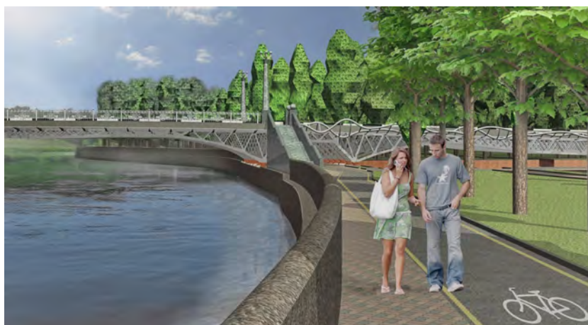
Рис. 3. Общий вид на мост после реконструкции
