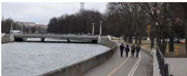
Рис. 2. Общий вид на мост до реконструкции. Вид с южного берега реки в северо-восточном направлении
