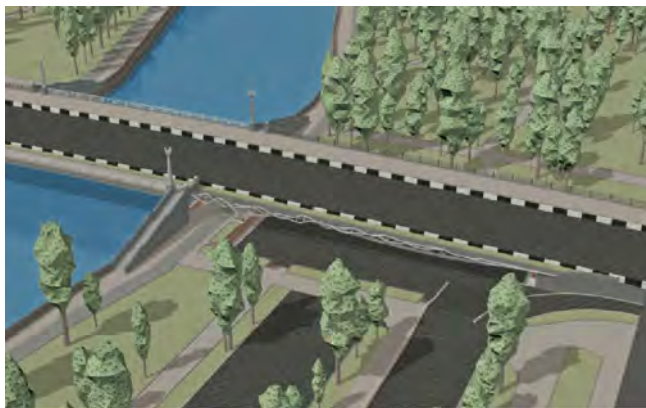
Рис. 4. Общий вид на узел пересечения ул. Янки Купалы и ул. Интернациональной с крыши жилого дома. Под пролетом № 1 организована парковка. Велодорожка и пешеходная дорожка по берегу проходят под пролетом № 2
