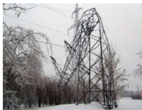
Рисунок 2 – Разрушенная опора ЛЭП под воздействием голо лёда
