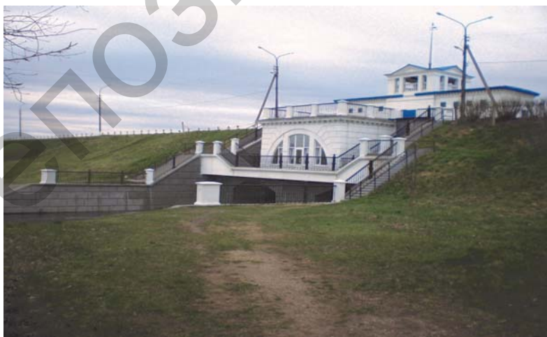
Рисунок 1 – Вид гидроузла со стороны нижнего бьефа
