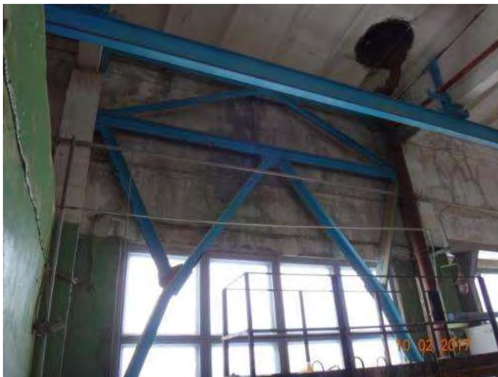
Рис. 4.3. Вертикальные стальные связи жесткости.
