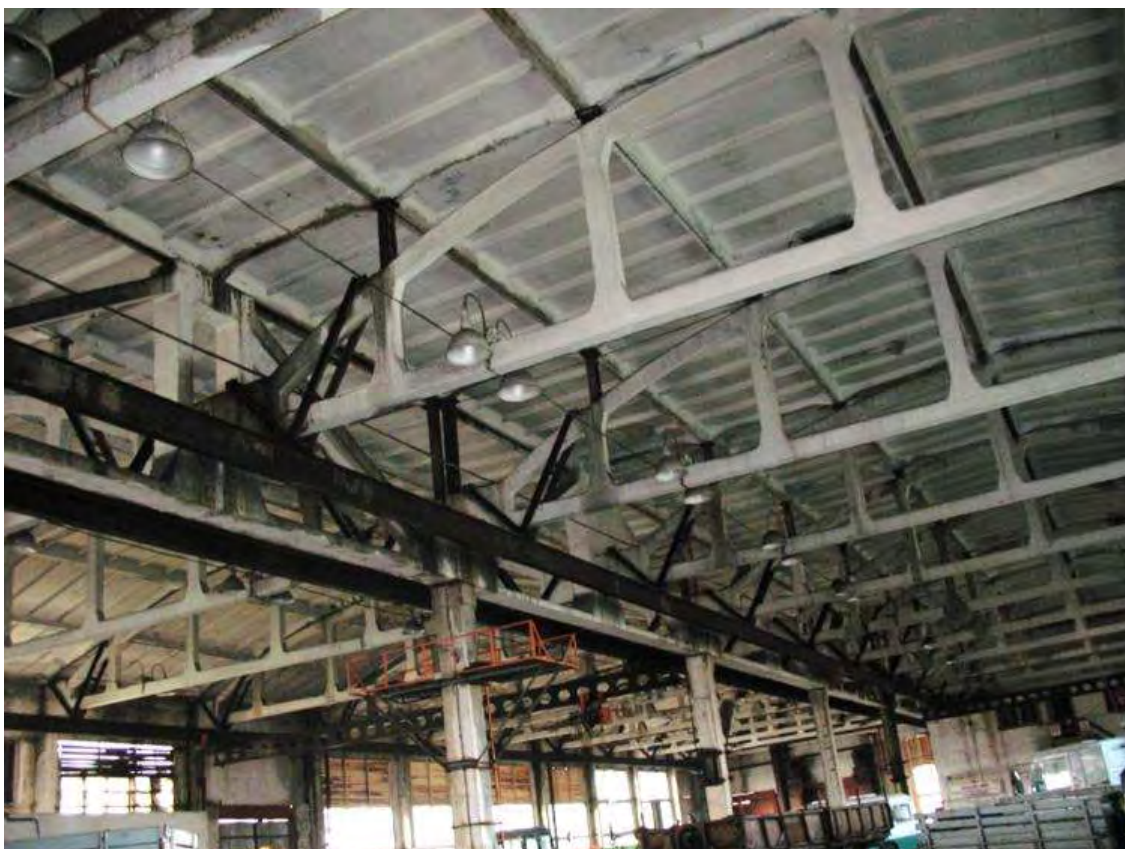
Рис. 4.2. Фото одноэтажного промышленного здания.
