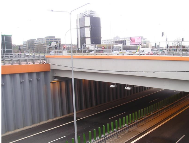
Рис. 5. Автодорожный виадук, г.Келце
