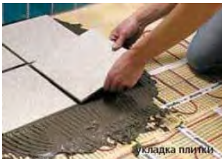
Рисунок 13.6 – Укладка пола из плитки
