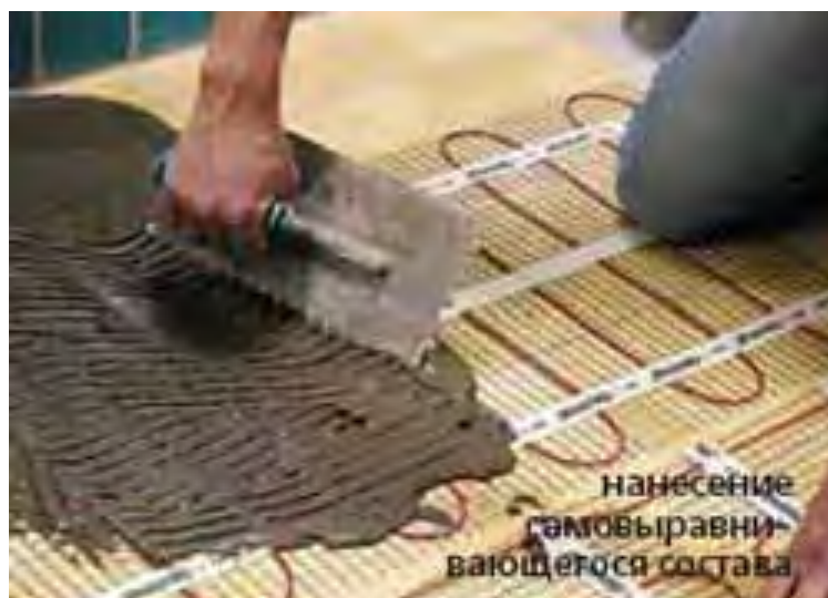
Рисунок 13.5 – Устройство стяжки под полы
