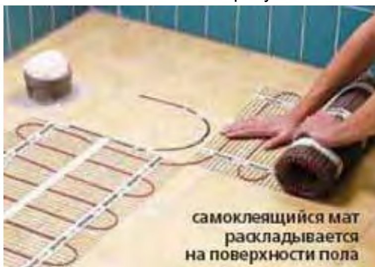
Рисунок 13.4 – Укладка электрических нагревательных матов
