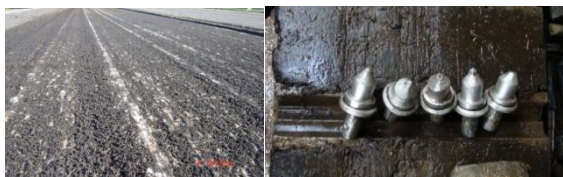
Профрезерованный участок трассы Р31 Часть опытных образцов после испытаний (40X+BK8)
