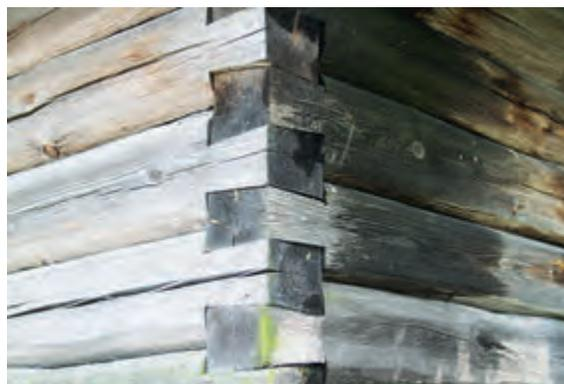
*Рис. 83. Срубная конструкция из дерева – «немецкий угол»*
