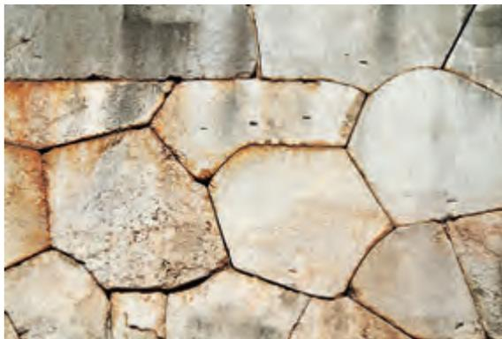
*Рис. 80. «Циклопическая» кладка*
