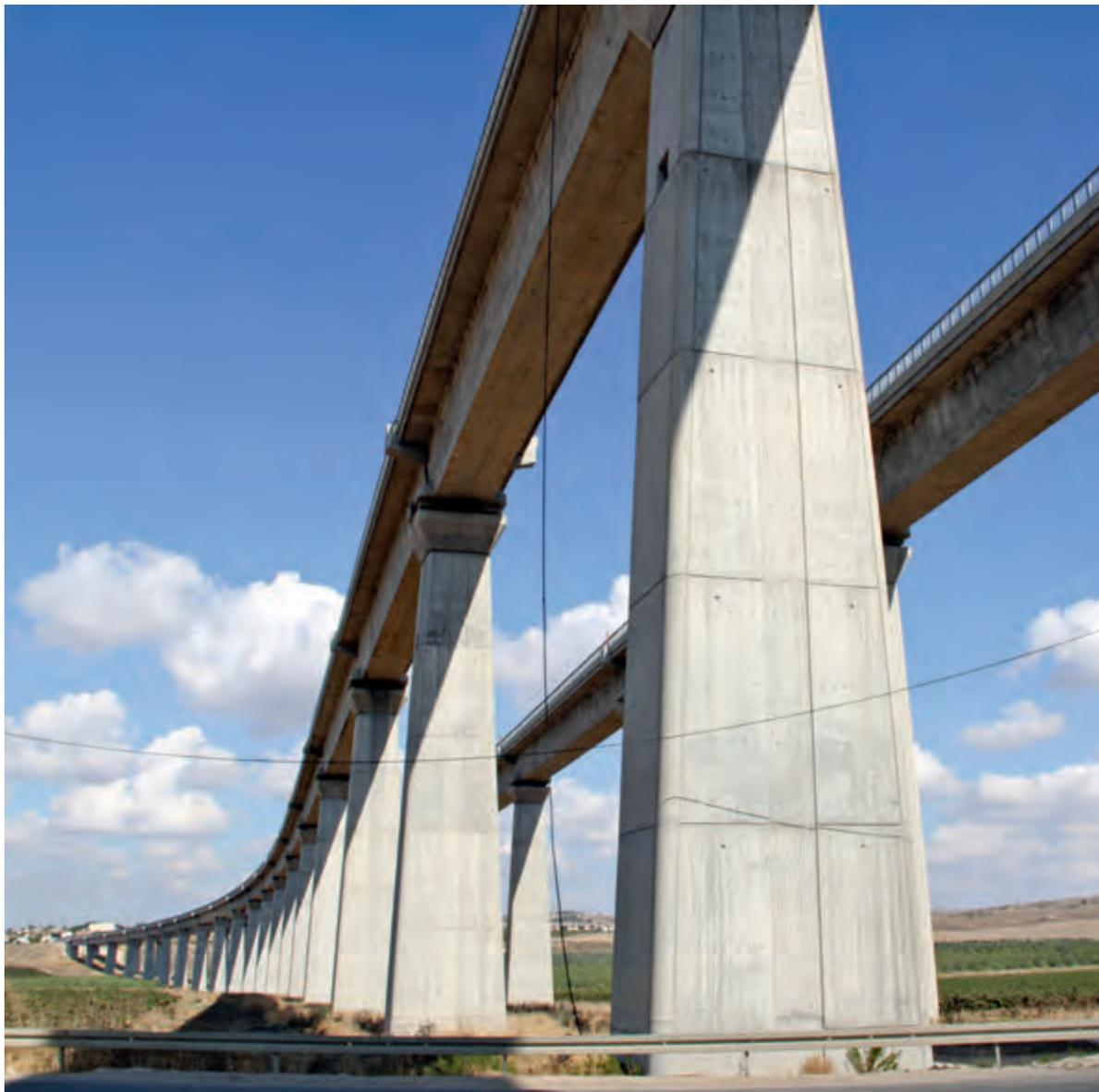
*Рис. 92. Железобетонная конструкция эстакады.
