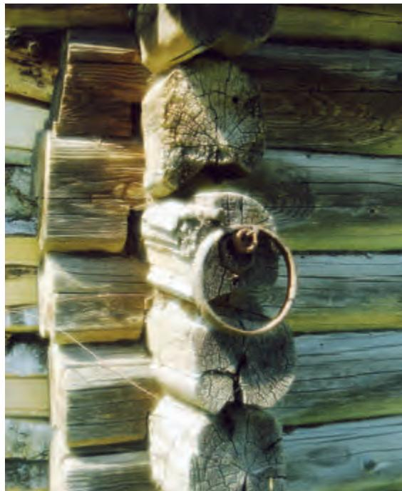
*Рис. 82. Срубная конструкция из дерева – «русский угол»*
