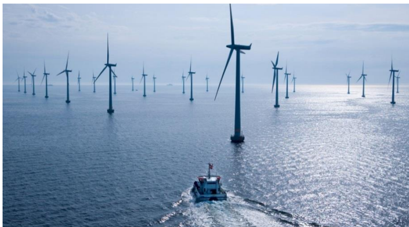
Рисунок 1- Первая плавающая электростанция в Норвегии
