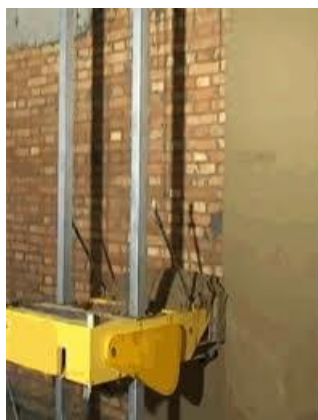
Рисунок 1 – Навесное оборудование строительных роботов для фасадных работ
