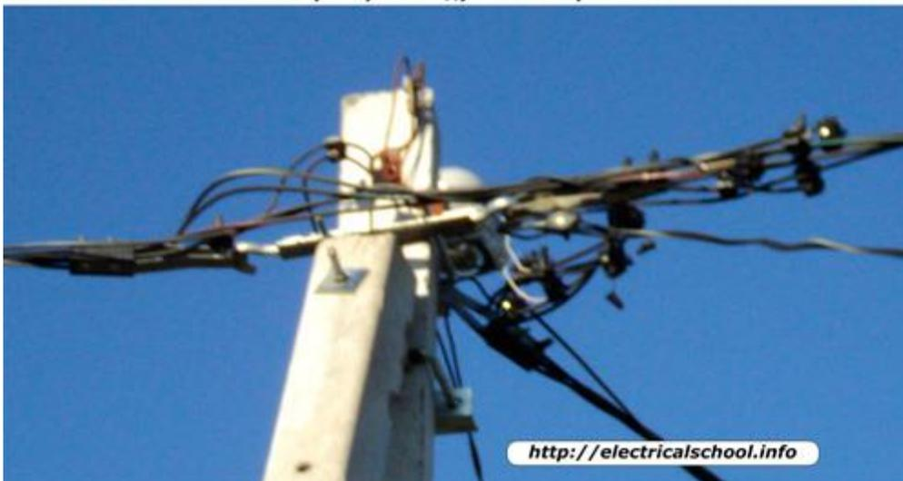
Рисунок 4. Крепление самонесущих изолированных проводов ВЛ-0.4 кВ
