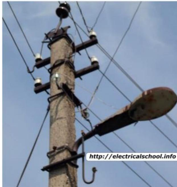
Рисунок 3. Опорные изоляторы на воздушной линии 0.4/0.2 кВ
