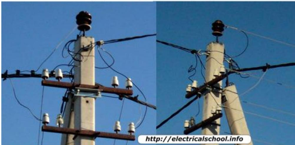
Рисунок 5. Штыревые фарфоровые изоляторы на опорах ВЛ-0.4 кВ с открытыми и самонесущими изолированными проводами
