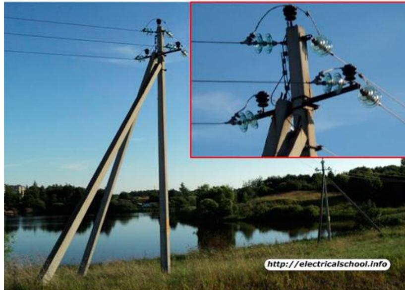
Рисунок 7. Натяжные гирлянды изоляторов на ВЛ- 10 кВ
