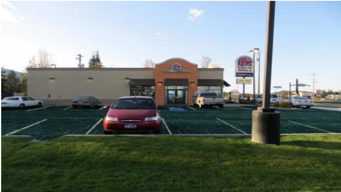
Рисунок 5. Парковка с покрытием SolarRoadways
