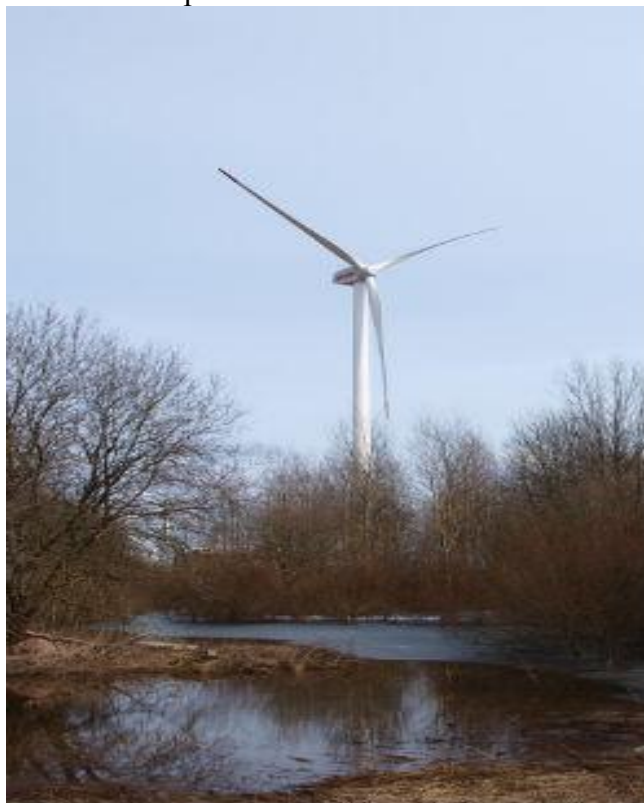
Рисунок 1 – Ветряная электростанция (ВЭС) в Грабниках
